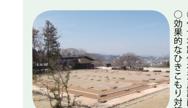
往時の建物規模や部屋割りを表現している仙台城本丸大広間の遺構表示
