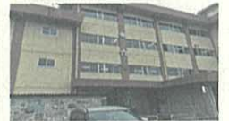
福室小学校は建替え整備がすすみます。
