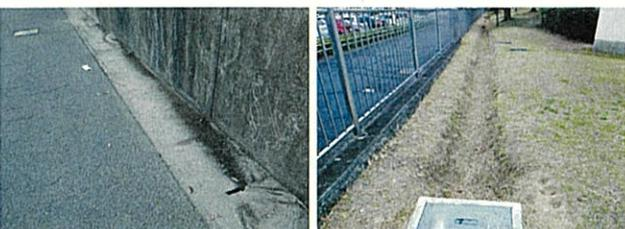
公園内に簡易的な側溝と排水溝を設置し、詰まっていた側溝の清掃をして頂きました。
