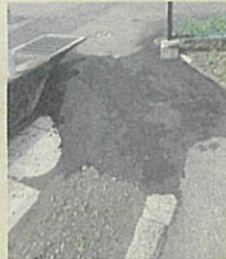
小鶴市菅住宅内の側溝脇の修繕
