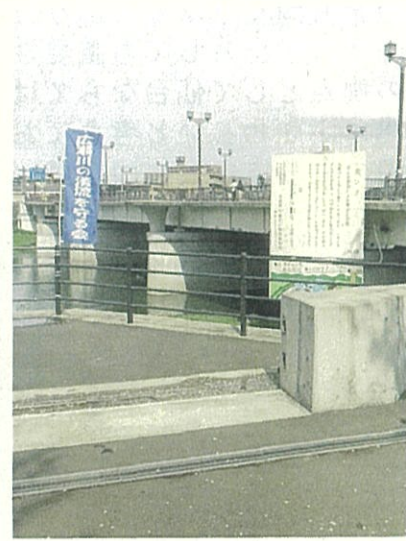
令和4年4月27日 委員会市内視察 広瀬橋
