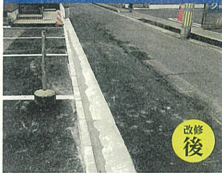
南小泉4丁目側溝整備
