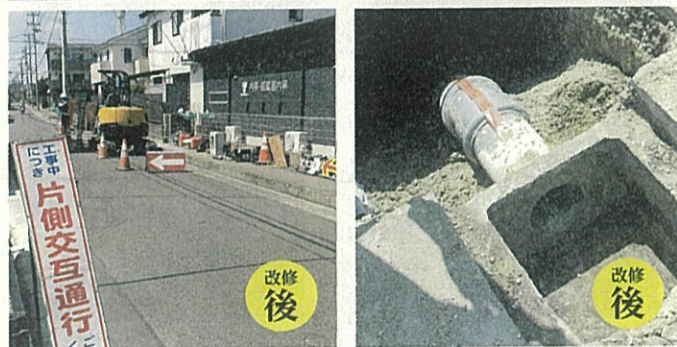
▲雨水が飲み込まず病院内浸水被害、排水溝を本管に接続改善
