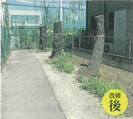
▲街路樹の伐採
