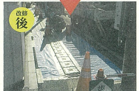
▲道路の凹みを修繕
