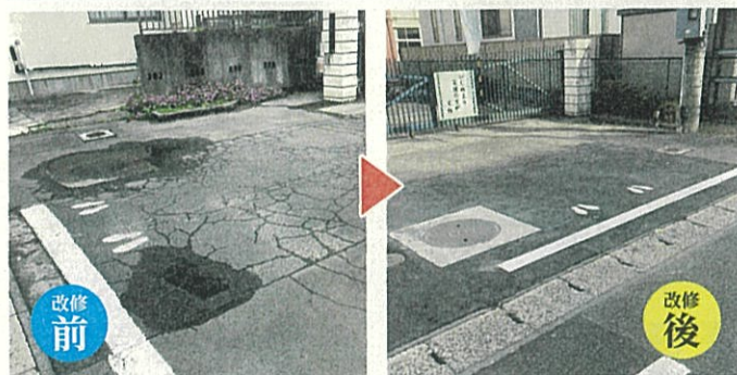
▲道路との段差がありつまずきの原因になっていたが再舗装で段差解消
