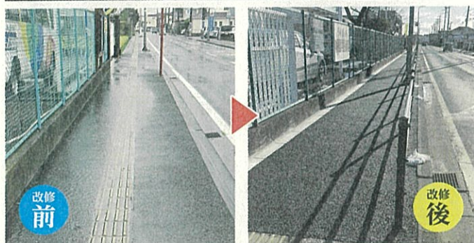
▲歩道の再舗装、安全柵設置で歩行者の安全を確保
