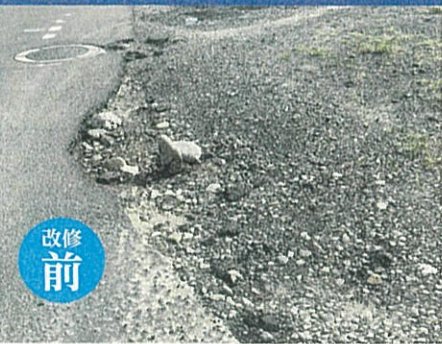
南小泉4丁目5の道路整備
