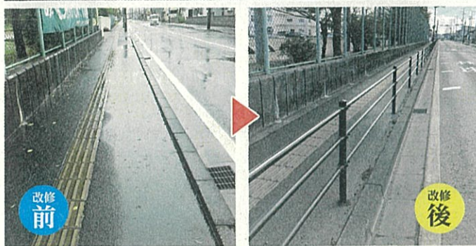
▲歩道を歩く小学生の安全を確保するため安全柵を設置
