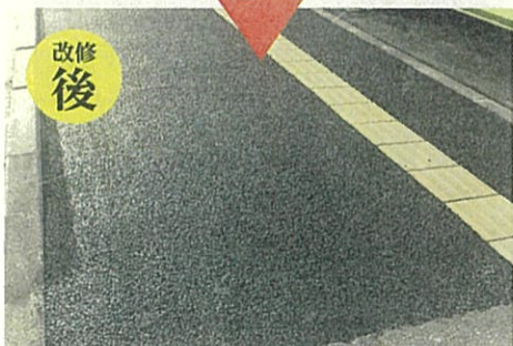
▲道路の凹みを修繕
