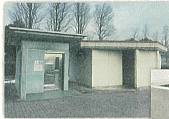
▲昔のトイレ建物
