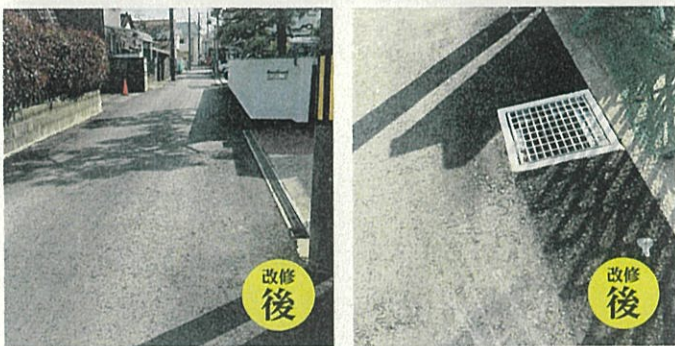
▲住民要望の痛んだ道路を再舗装、側溝蓋を新設
