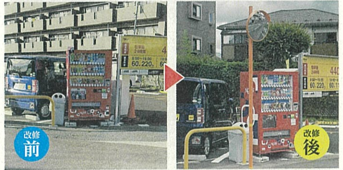
▲見通しの悪い交差点にカーブミラーを新設
