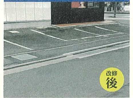
南小泉4丁目14の側溝整備
