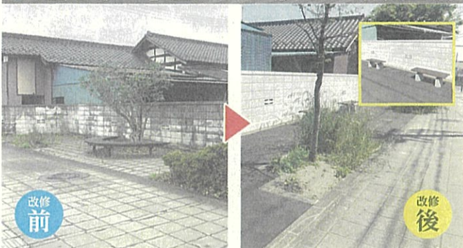
▲この場所は歩道板が敷き詰められており、隙間から雑草が生える状態。ベンチも老朽化しておりアスファルト舗装。新たにベンチも二台設置し住民が憩える環境整備ができました。
