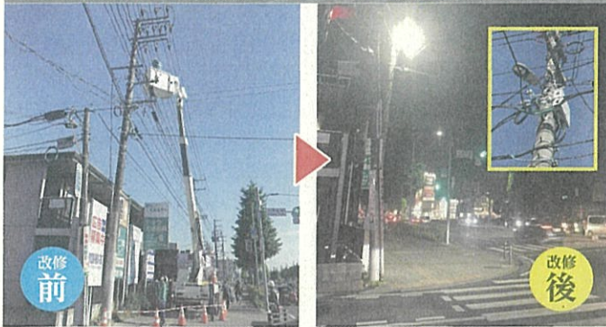
▲バス路線変更でバスが左折する交差点に歩道、横断歩道を照らす照明が片方にしかなくとても危険でした。新たに照明灯を設置してもらい安全を確保しました。
