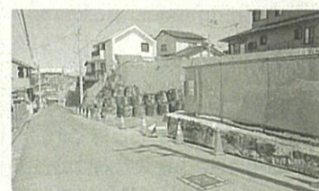
緊急災害工事 荒巻本沢3丁目地内
