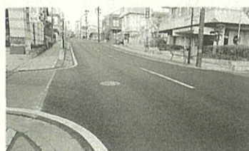
道路修繕 (安全対策) 中山4丁目地内
