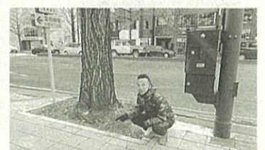
根上り修繕 (安全対策) 一番丁4丁目地内
