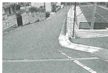
道路整備 (安全対策) 荒巻本沢地内
