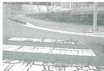
交差点段差解消 川平1丁目地内
