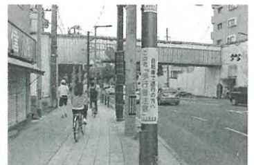
看板設置 (安全対策) 昭和町歩道橋前
