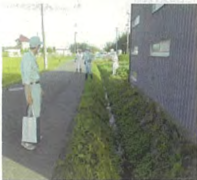
(昭和北の用排水路現地調査)
