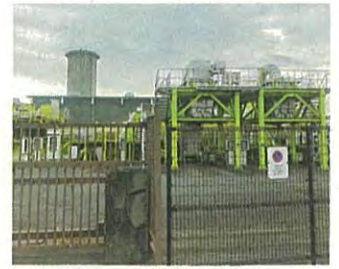
▲運用開始から50年が経過した郡山ポンプ場
