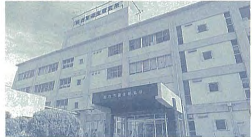
仙台市衛生研究所（若林区）
