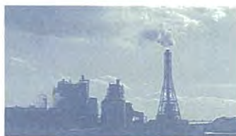
仙台パワーステーション(仙台港・宮城野区)
