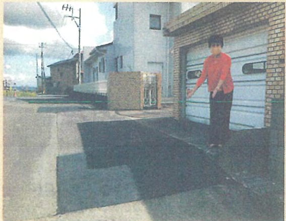
道路の段差解消(燕沢地区)
