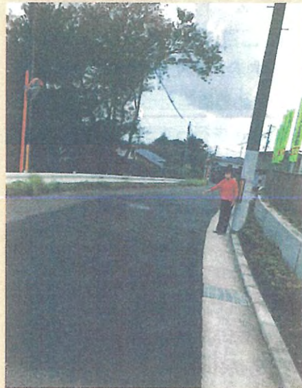
車道の整備(西山地区)
