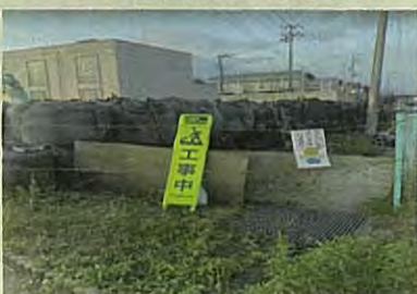
写真① 台風後の浚渫作業
