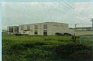
田子排水機場 (福住町)
