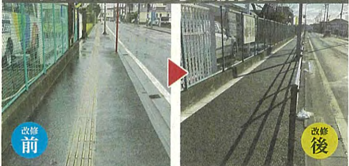
▲歩道の再舗装、安全柵設置で歩行者の安全を確保
