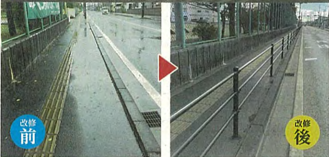
▲歩道を歩く小学生の安全を確保するため安全策を設置
