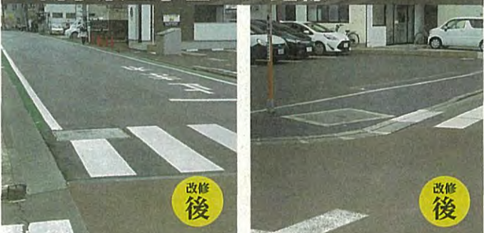
▲道路の再舗装刑務所迄まで、歩道も再舗装安全確保
