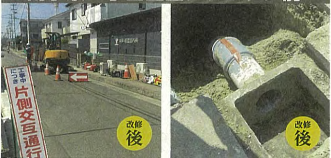
▲雨水が飲み込まず病院内浸水被害、排水溝を本管に接続改善
