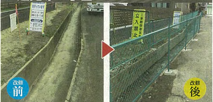
▲から堀で子供がはなて遊び危険な状態、防護柵を設置し安全確保
