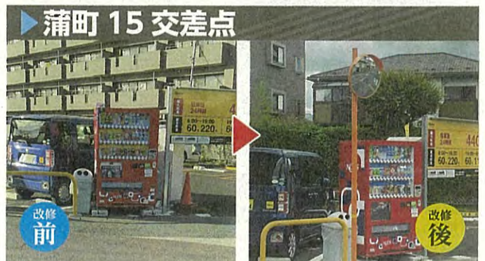
▲見通しの悪い交差点にカーブミラーを新設
