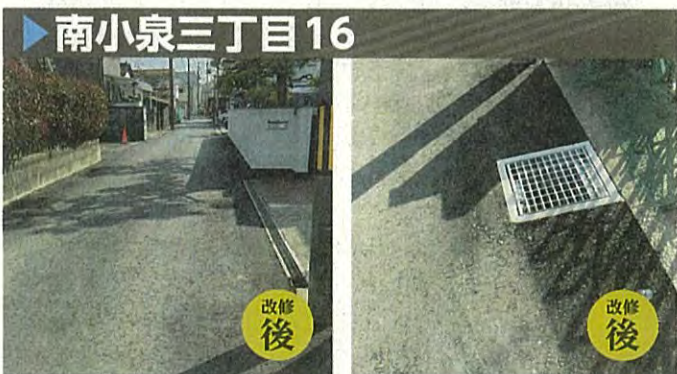
▲住民要望の痛んだ道路を再舗装、側溝蓋を新設
