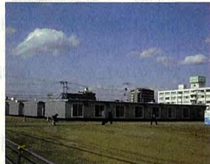
建設中のプレハブ仮設住宅
