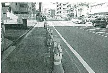
歩道整備 (歩行者安全対策) 木町通2丁目地内
