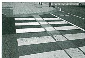
エスコートゾーン修繕 青葉区役所前
