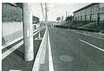
道路整備 (安全対策) 中山6丁目地内
