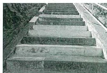
市有通路修繕 滝道集会所付近
