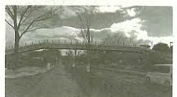
3月末に完成予定の歩道橋
