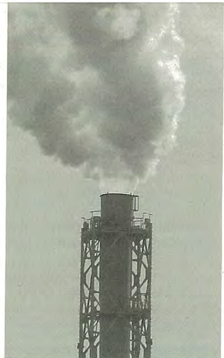
稼働中の石炭火力発電所 「仙台パワーステーション」
