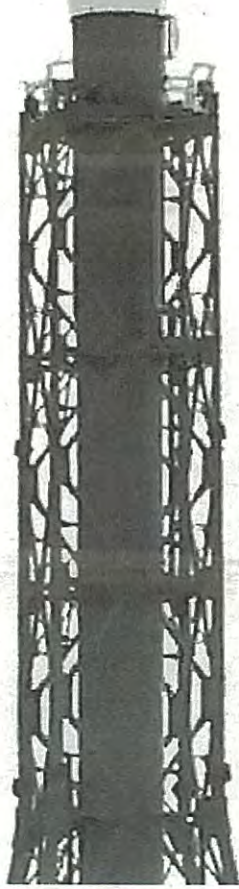
稼働中の仙台パワーステーション(仙台港=宮城野区)
