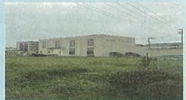
田子排水機場（福住町）
