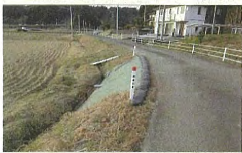
茂庭字向根地区市道法面改修
