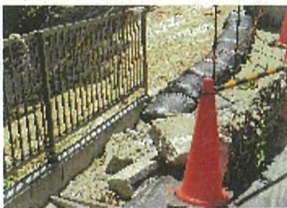
太白3丁目佐藤宅法面改修
