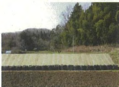
坪沼北原地区農地法面復旧
