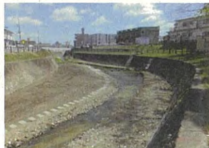
鉤取笹川農業用取水口改修
