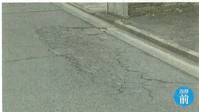
▲文化町。下水の陥没により道路がへこんだ状態でしたが、陥没した下水工事合わせて、道路の再舗装を実現いたしました。
