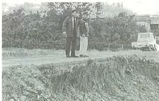
台風19号の被害地区の現場調査(泉区野村地区)
