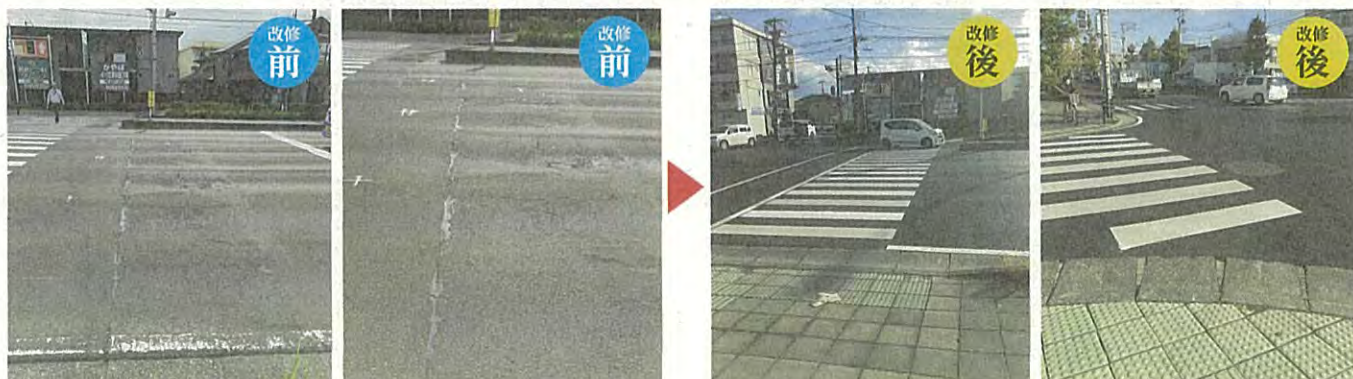
宮城の萩大通りで一番車両通行が多い交差点。輪だちがひどくバイクの自損事故も数件あり とても危険でしたが2年越しの要望が通り再舗装整備。
