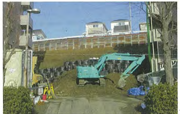
復旧が進む市道法面崩壊現場
