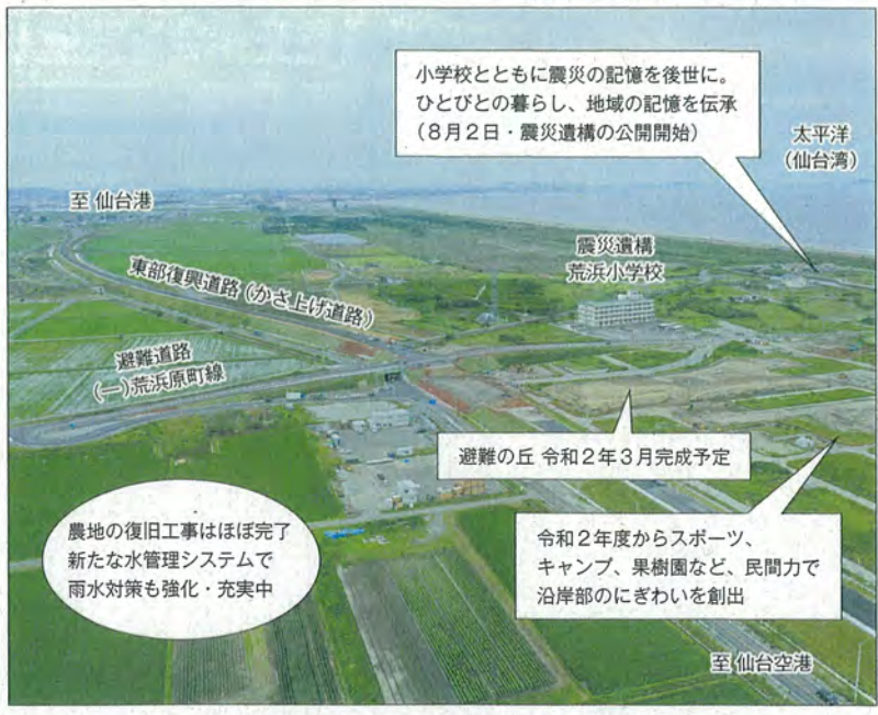
▲ 整備状況(令和元年7月5日撮影) <荒浜交差点付近>
