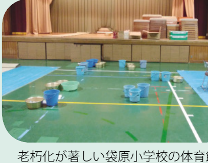
老朽化が著しい袋原小学校の体育館（昨年の台風19号による雨漏りの様子）
