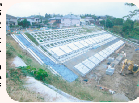
宅地の復旧工事の様子 泉区南光台六丁目地区(平成25年9月)
