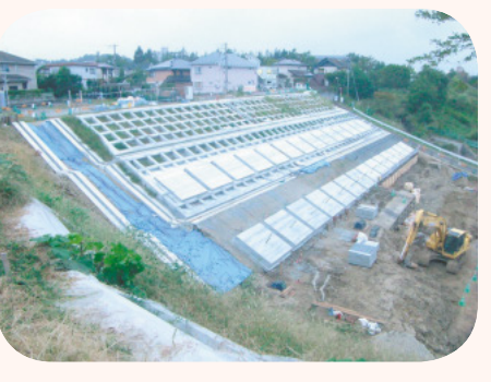
宅地の復旧工事の様子 泉区南光台六丁目地区 (平成25年9月)
