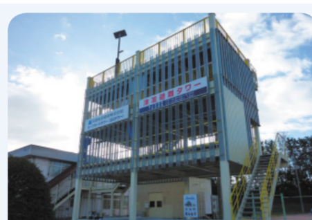
東部沿岸地域に建設された津波避難タワー
