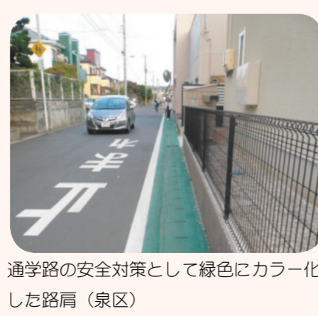
通学路の安全対策として緑色にカラー化した路肩(泉区)
