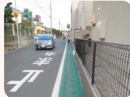
通学路の安全対策として緑色にカラー化した路肩(泉区)
