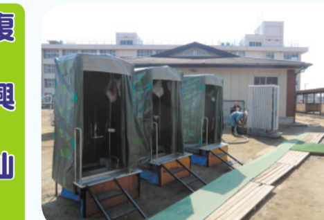
避難所に設置された仮設トイレ
