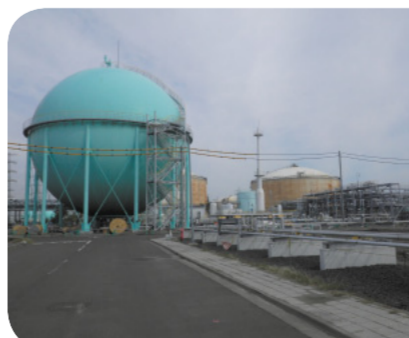
復旧が進むガス局港工場
