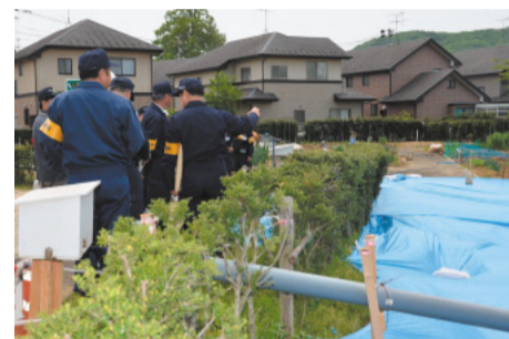
地滑りの発生により、法面等の崩壊が発生した 西花苑地区
