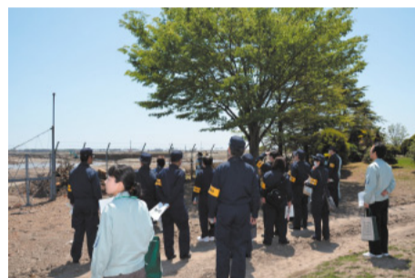
施設設備が津波により浸水した農業園芸 センター周辺
