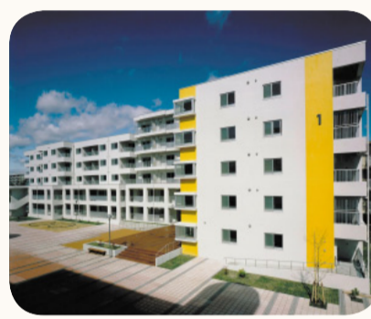
現在整備中の鶴ヶ谷第一市営住宅
