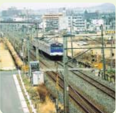
(仮称) 新田東駅建設予定地
