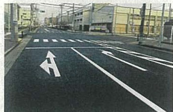
信号の調整・路面・排水の改良
