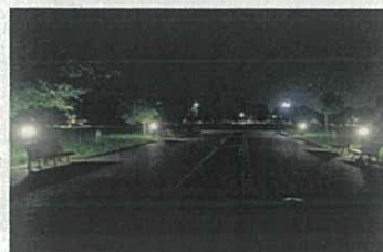
都市公園への照明設置
