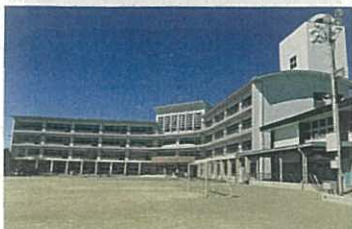
学校施設の修繕・改築
