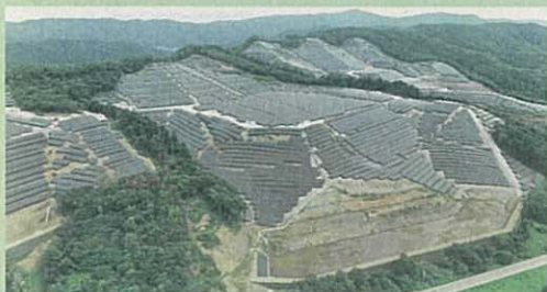
※この写真は参考です。全国的に、森林伐採を伴うメガソーラー設置が問題となっています。
