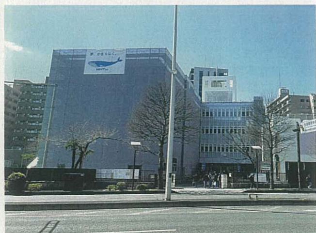
大規模改修工事中の仙台市立五橋中学校(令和8年3月19日撮影)
