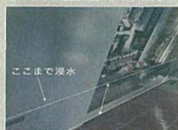
【制御盤浸水状況】
