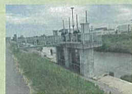
仙石雨水ポンプ場
