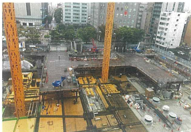
工事が着実に進展しつつある本庁舎建替工事
