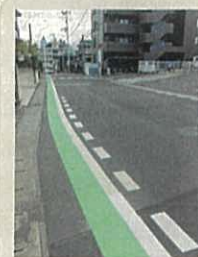
西多賀2丁目5付近(西多賀小通学路)の道路舗装とグリーンベルトの設置
