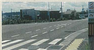
ウジエ西多賀店周辺の旧286号線と北側市道の一部舗装、郡山折立線交差点の右折ポケット引き直し
