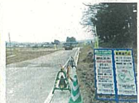
泉塩釜線西工区工事
